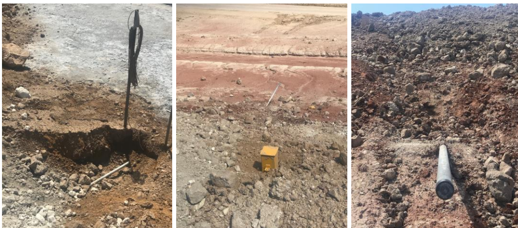
Figures 10 f) g) and h) TSF piezometer repairs
